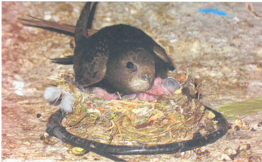
Die Talbrücke Ronnewinkel ist für die Mauersegler als Brutkolonie attraktiv, weil die 16 etwa 40 Meter langen Brückenkammern mehr als 250 Einfluglöcher bieten. Die Nestern sind mit einem Antennenring verkabelt. Fotos: Universität Siegen
